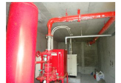
※機器共撤去 (消火ポンプ1.8×0.6×H1.0 発電機1.3×0.9×H1.5)
